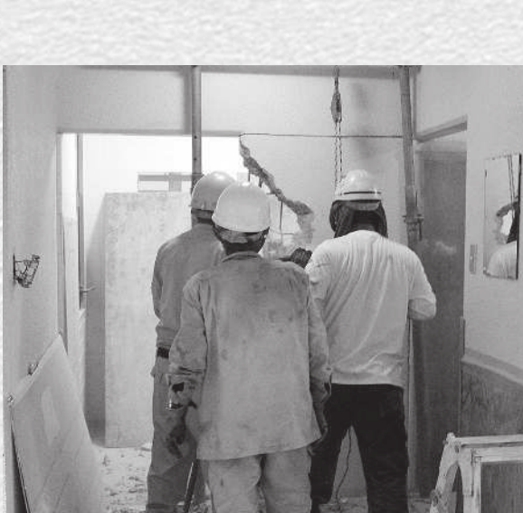
トイレ改修解体
