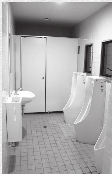
既存トイレ改修
