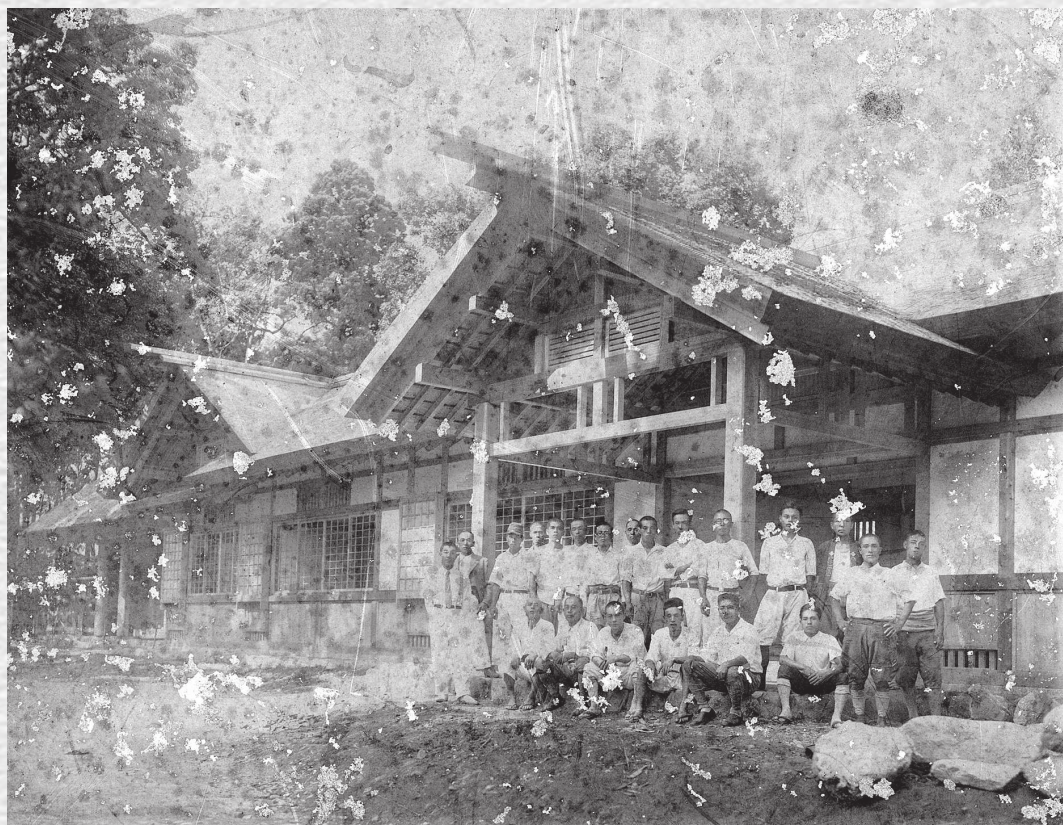
社務所建設工事
