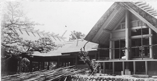
社殿建設工事 (昭和15年)
